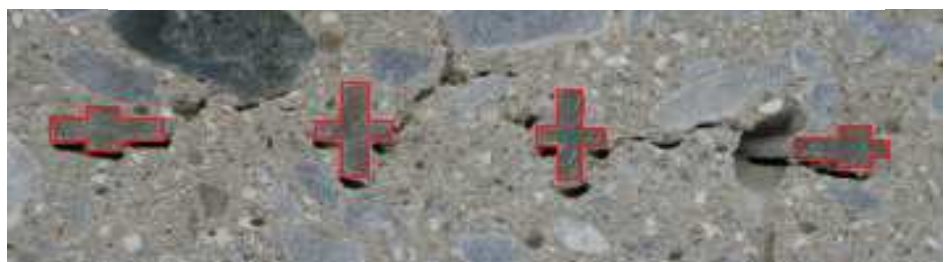
コンクリートを打設したドーナツ型スペーサの切断面
